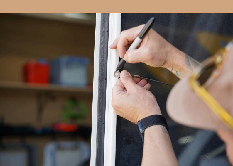
MEASURE BOTH MARKINGS TO ENSURE THE BAG WILL SIT LEVEL ON THE DOOR.
